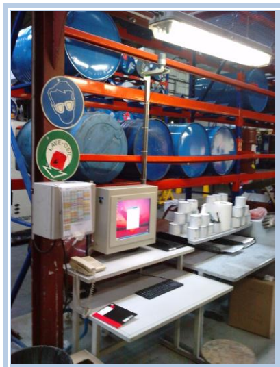
Antenne wifi et panel pc Kermaz en zone2.
